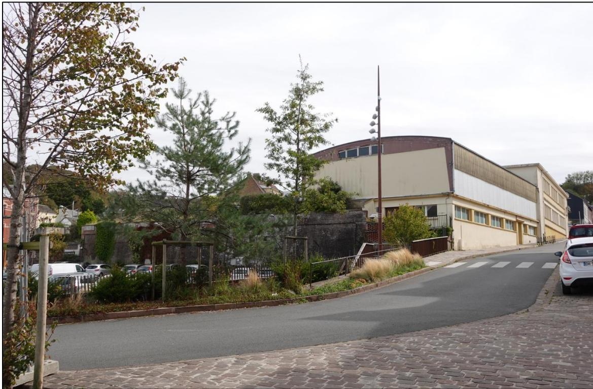
Vue sur le site du projet depuis la rue du 11 novembre 1918 et les abords de l'église
