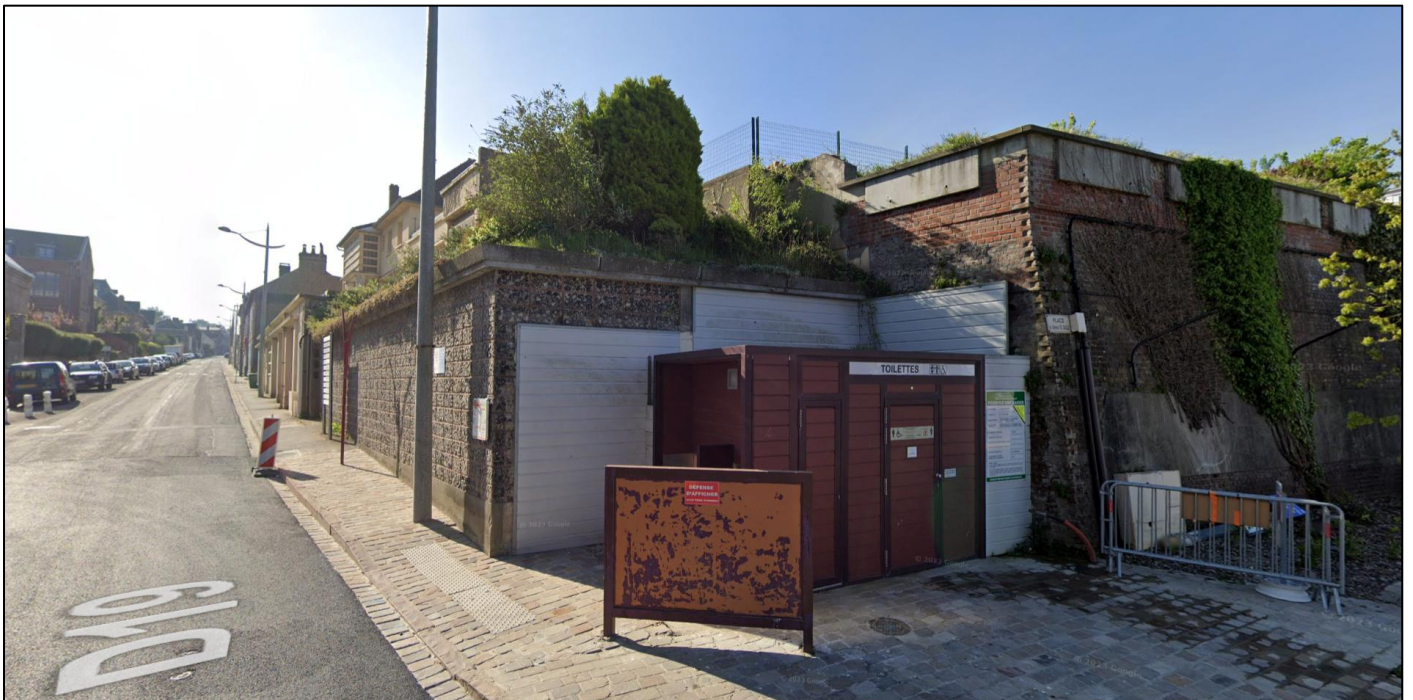
Vue depuis l'Avenue du Général Leclerc aux abords du site du projet
