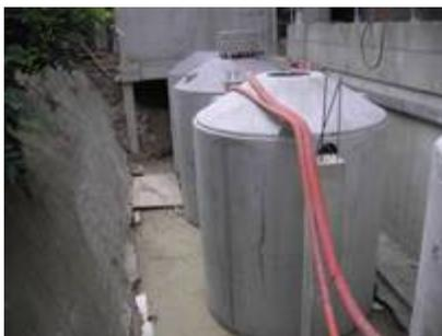
Pour les capacités allant jusqu'à 12.5 m<sup>3</sup>, pouvant ensuite être assemblées en série, il existe des citernes préfabriquées en béton étanche, cylindriques, forme qui présente l'avantage de bien répartir l'effort sur le sol.
