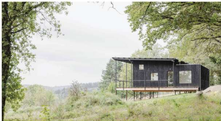
Saint-julien Maison sur pilotis - Cigüe
