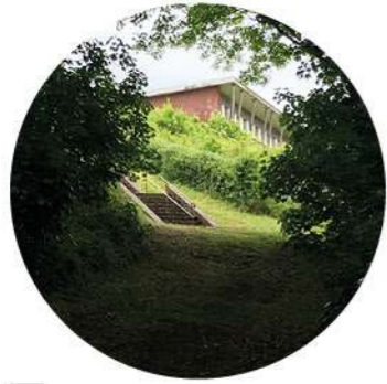
4 Chemin dans le bois vue vers le bâtiment des colonies
