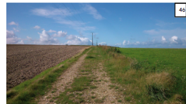
Utilisation de la trame viaire agricole existante interdite aux VL sauf riverains. Cheminement composé de 2 bandes de circulation en béton accompagnées d'un espace traité en mélange terre-pierre
