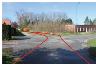
Passage derrière la clôture (enrobé silmer)
