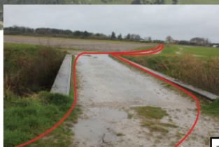
Mise en place de garde-corps.
