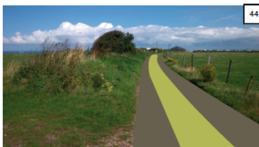
Utilisation de la trame viaire agricole existante interdite aux VL sauf riverains. Cheminement composé de 2 bandes de circulation en béton accompagnées d'un espace traité en mélange terre-pierre
