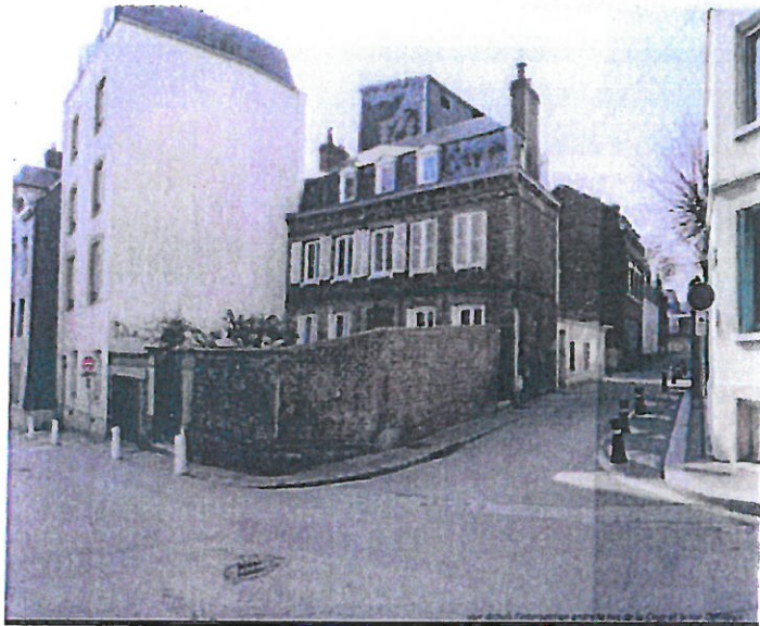
Extension d'une maison individuelle PCMI 7 Photographie du terrain dans son environnement proche
